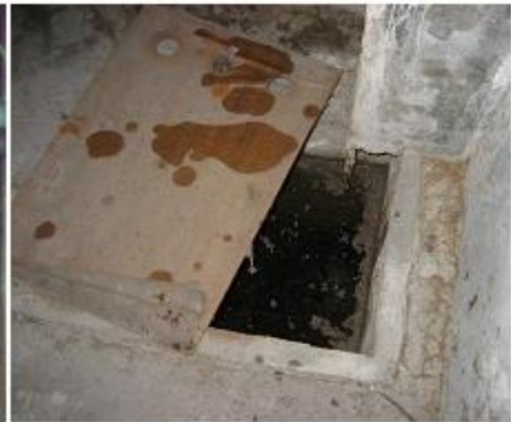
地下室污水池
