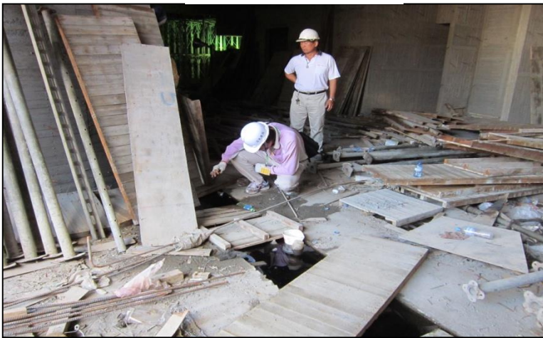
車道下方水溝
