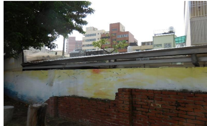
天溝(屋簷排水槽)
