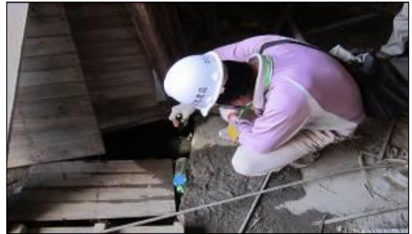
車道下方水溝
