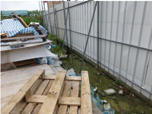
建築工地圍牆周邊
