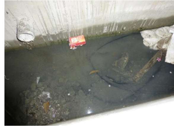
建築工地地面
